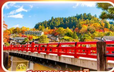
สะพานนากะบาชิ
