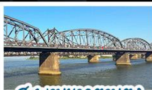
สะพานขาดตานตง
