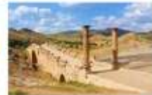
สะพานเซเวอร์วัน
